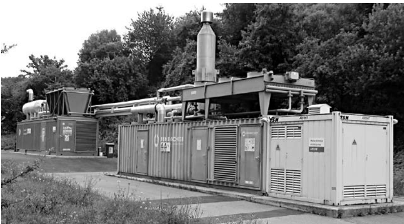
Slika 2.: Mala plinska elektrarna na odlagališču nenevarnih odpadkov Bukovžlak, spredaj 625 kWe agregat in zadaj 1.063 kWe agregat.
