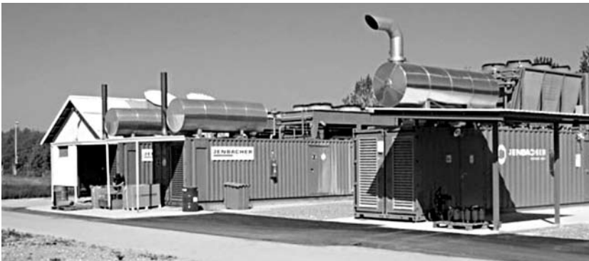
Slika 1.: Mala plinska elektrarna na odlagališču nenevarnih odpadkov Barje [4].
