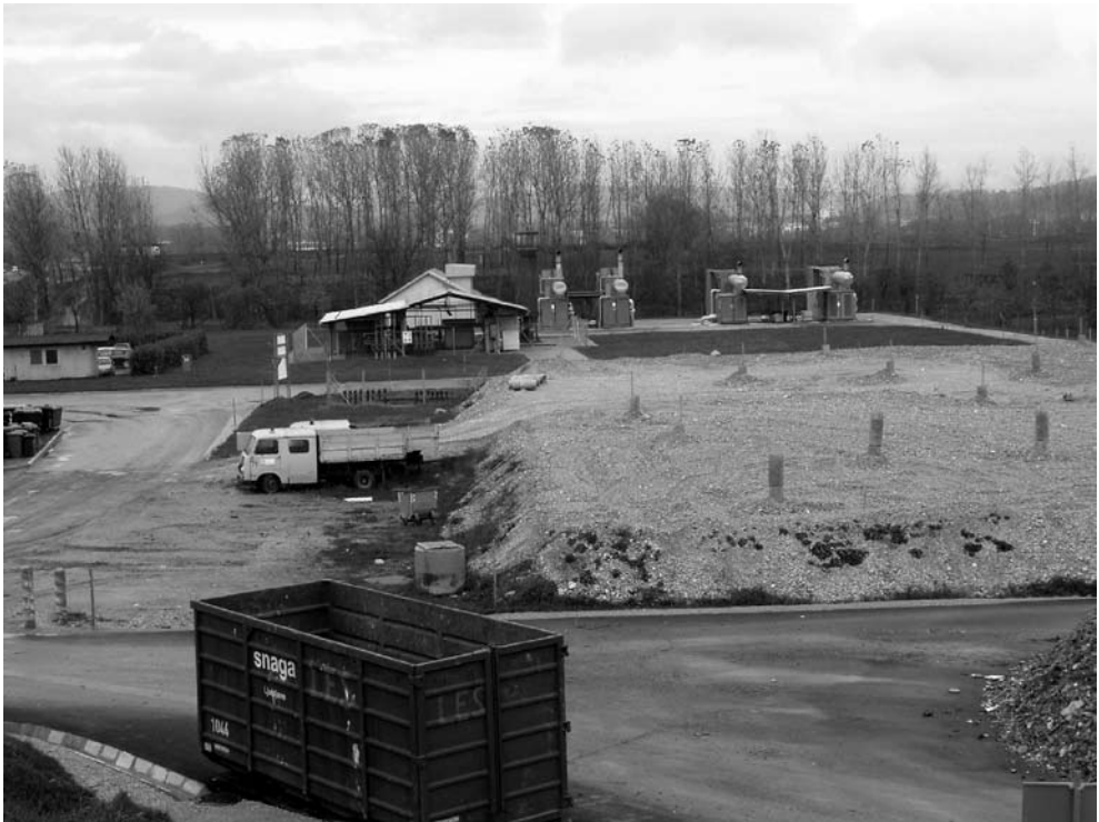
Slika 2.: Predobremenilni nasip za konsolidacijo terena pred začetkom gradnje.
