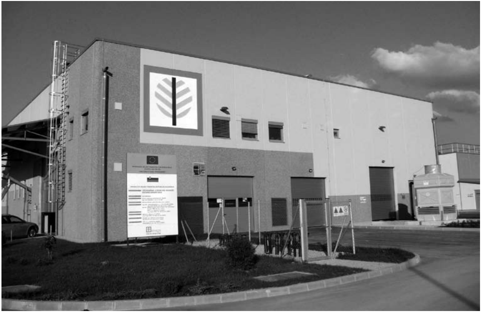
Slika 4.: Tehnološka stavba čistilne naprave Barje.
