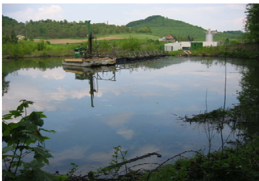
Odlagališče pred začetkom sanacije
