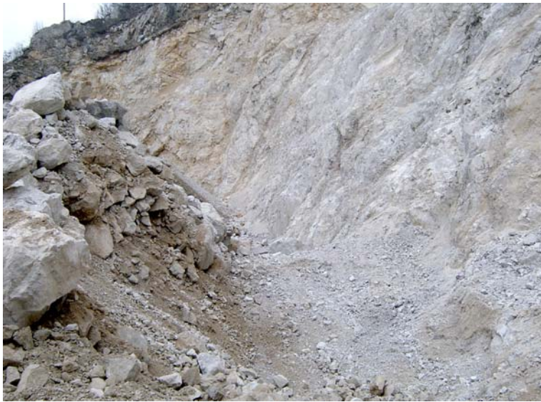
Slika 6.: Nasip in jarek med brežino kamnoloma in kolektorjem odpadnih vod. Skupna višina jarka in nasipa je 8 m.
