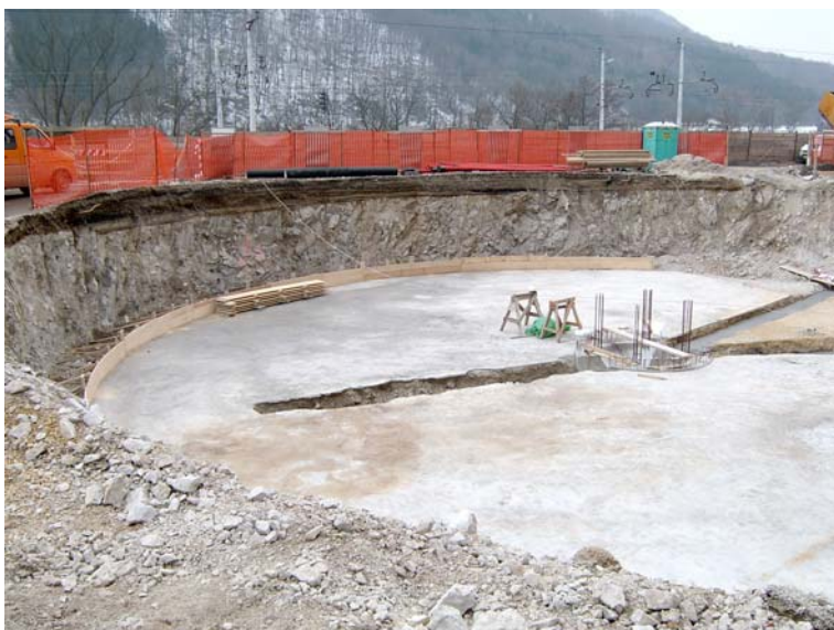
Slika 8.: Izdelava kolektorja odpadnih vod.
