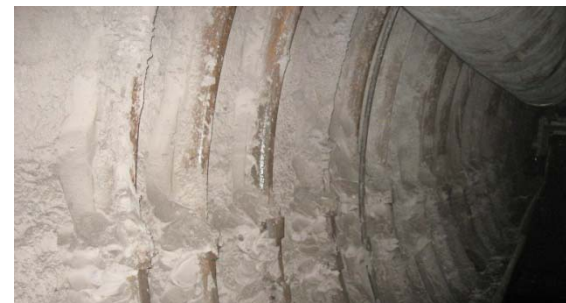
Končni izgled proge izdelane z loki TH29 na medsebojni oddaljenosti 0,5 metra
