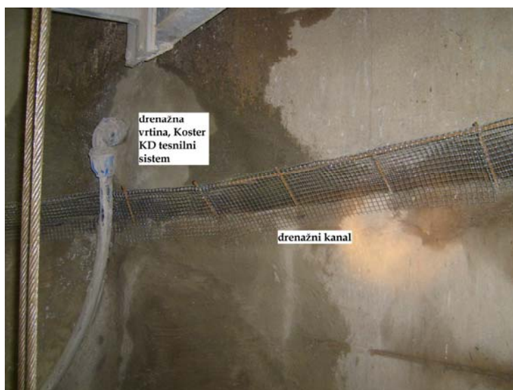
Slika 7.: Izvedeni drenažni ukrepi v jašku Borba
