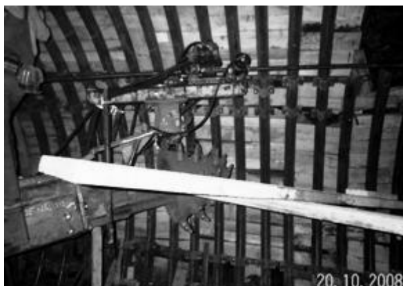
Slika 4.: Vrtalna garnitura Diamec 232 na napredovalnem stroju (arhiv PV)
