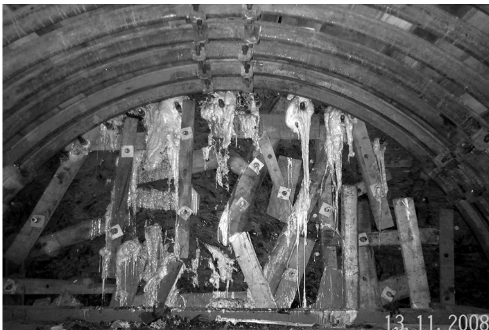
Slika 9.: Varovanje čelne stene , cevni ščit po obodu stropa (arhiv PV)
