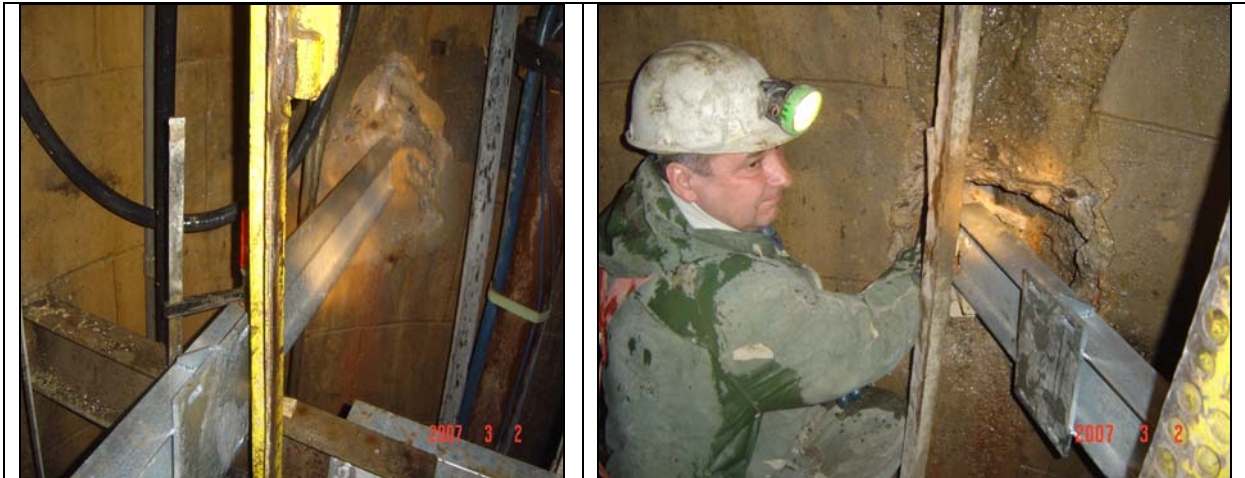
Slika 3.: V ležišče vgrajen levi bočni nosilec in vgrajevanje levega bočnega nosilca INP160
