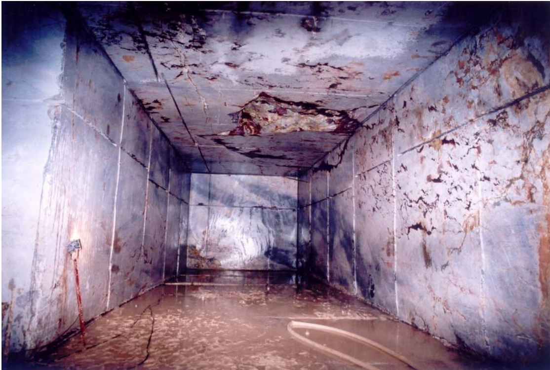
Slika 3.: Podzemno pridobivanje. Uvodni del galerije, prereza 5,2 x 4,3 m, z značilnim zruškom iz stropa zaradi neugodne lege prekinitvenih ploskev; kamnolom Hotavlje, stanje 2007
